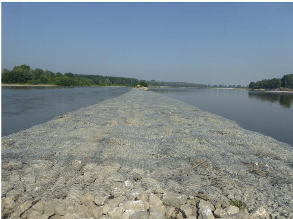
Foto 5: Immagine del pennello al termine dell'intervento MN-E-37_NI
