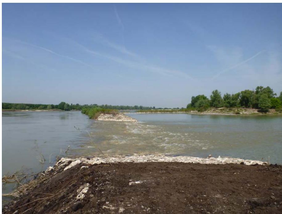
Foto 1: Immagine del pennello della curva 14 al termine dell'intervento di abbassamento
